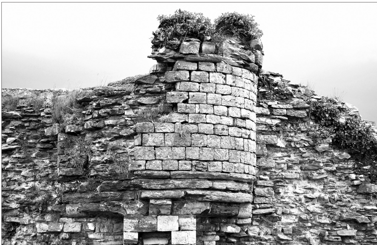
Détail d'une des tourelles sur contrefort.
