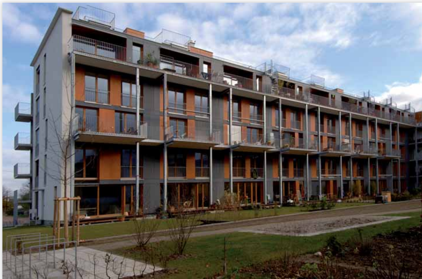
Ensemble de logements à Fribourg en Allemagne © Fabrice Dor (SPW-DG04)
