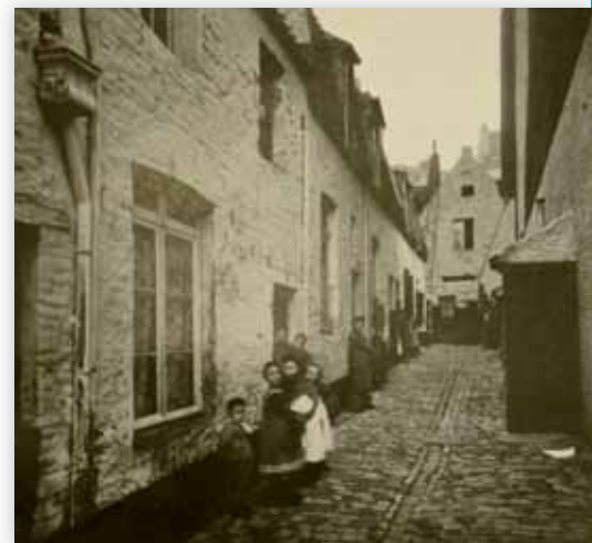
Exemple d'impassé à démolir par la loi d'expropriation par zones.
