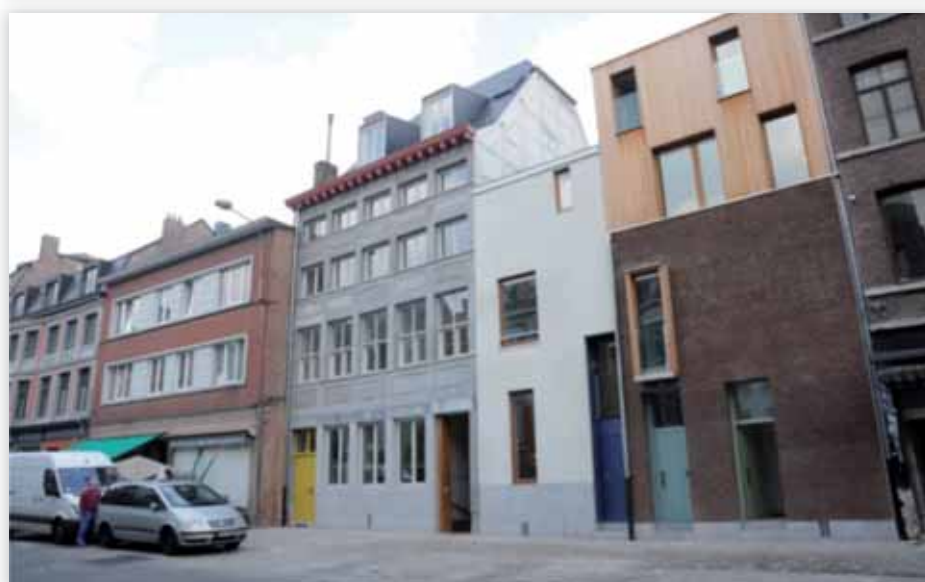
Photos de la rue Saint-Séverin avant/après travaux (phases 1 et 2). © Urbanisme Ville de Liège JP. ERS
