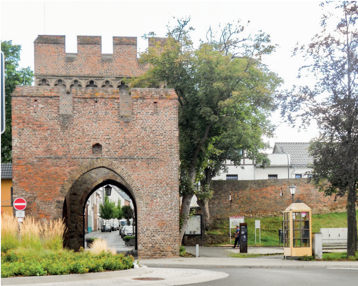
La voie Reims-Cologne dénommée Römerallee passant sous la porte de l'enceinte médiévale à Zulpich. Photo M.-H. CORBIAU.
