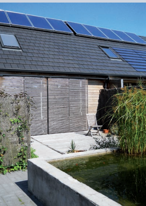
Les consommations de chauffage des logements du quartier du Pic au Vent à Tournai sont minimisées (standard passif) grâce à une isolation renforcée des parois, l'orientation et la mitoyenneté des logements. La production de chaleur est assurée en partie par des énergies renouvelables.
