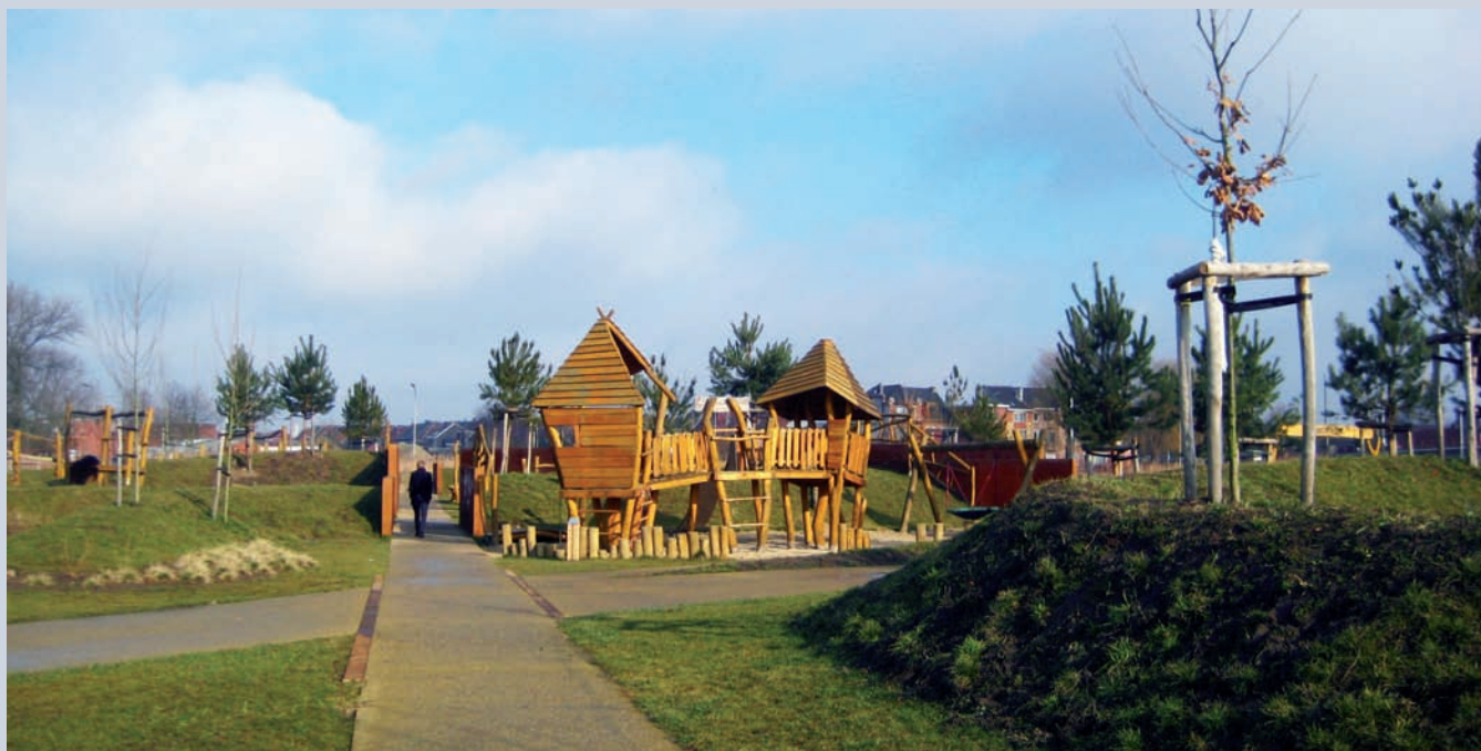
Le projet de rénovation des sites de Trefil Arbed à Gand intègre des espaces collectifs de grande qualité qui répondent aux besoins des habitants et des PME localisées sur le site.
