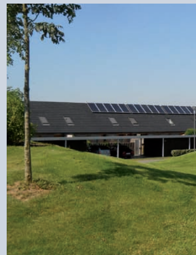
Au Pic au Vent à Tournai, les déblais sont réutilisés sur le site afin de créer une dynamique dans les espaces verts, ce qui apporte une plus-value paysagère au quartier.
