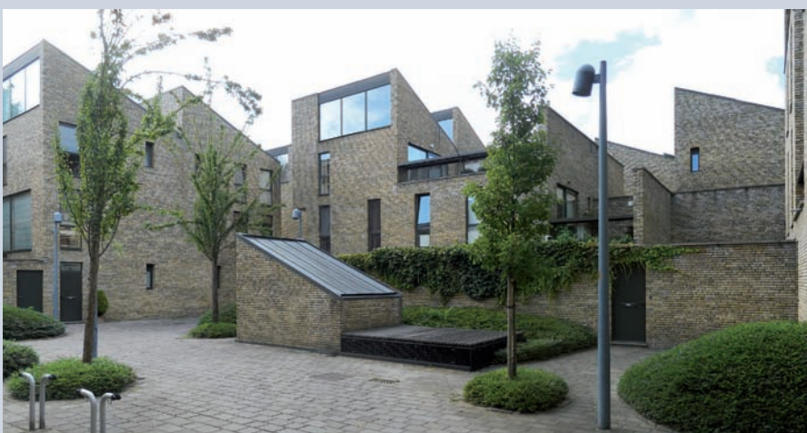
La qualité de vie générée par une grande densité est fortement liée au traitement des espaces publics. Dans le quartier « 't Pandreitje » à Brugge (109 logements/hectare urbanisé), la végétation est utilisée pour définir et qualifier les espaces extérieurs. Elle permet d'établir des limites plus ou moins franches entre des espaces de statuts et de rôles différents, en créant parfois des écrans protecteurs vis-à-vis des regards ou en formant des limites souples entre les cheminements piétons et les voiries.
