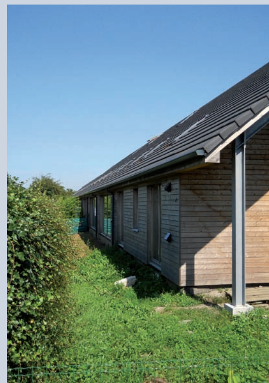
Le quartier du Pic au Vent à Tournai a été conçu « gros œuvre fermé ». Chaque occupant peut ainsi adapter l'aménagement intérieur de son logement de façon personnalisée. Le recyclage des logements en fin de vie est également envisagé.
