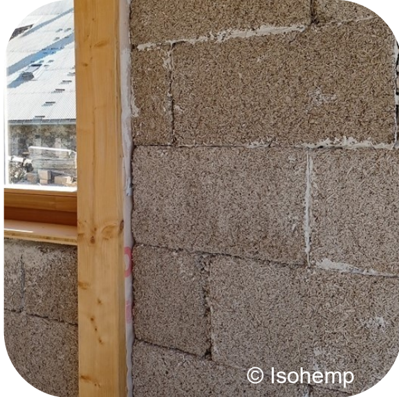
Blocs chaux-chanvre et Structure bois
