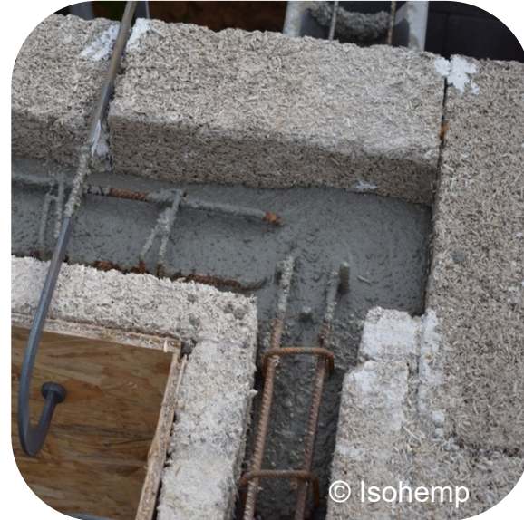
Blocs chaux-chanvre et Structure béton armé Système Hempro (Isohemp)
