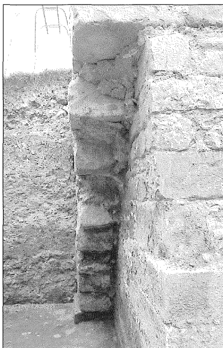
La chapelle du château : sondage sud, mur en escalier inversé.
