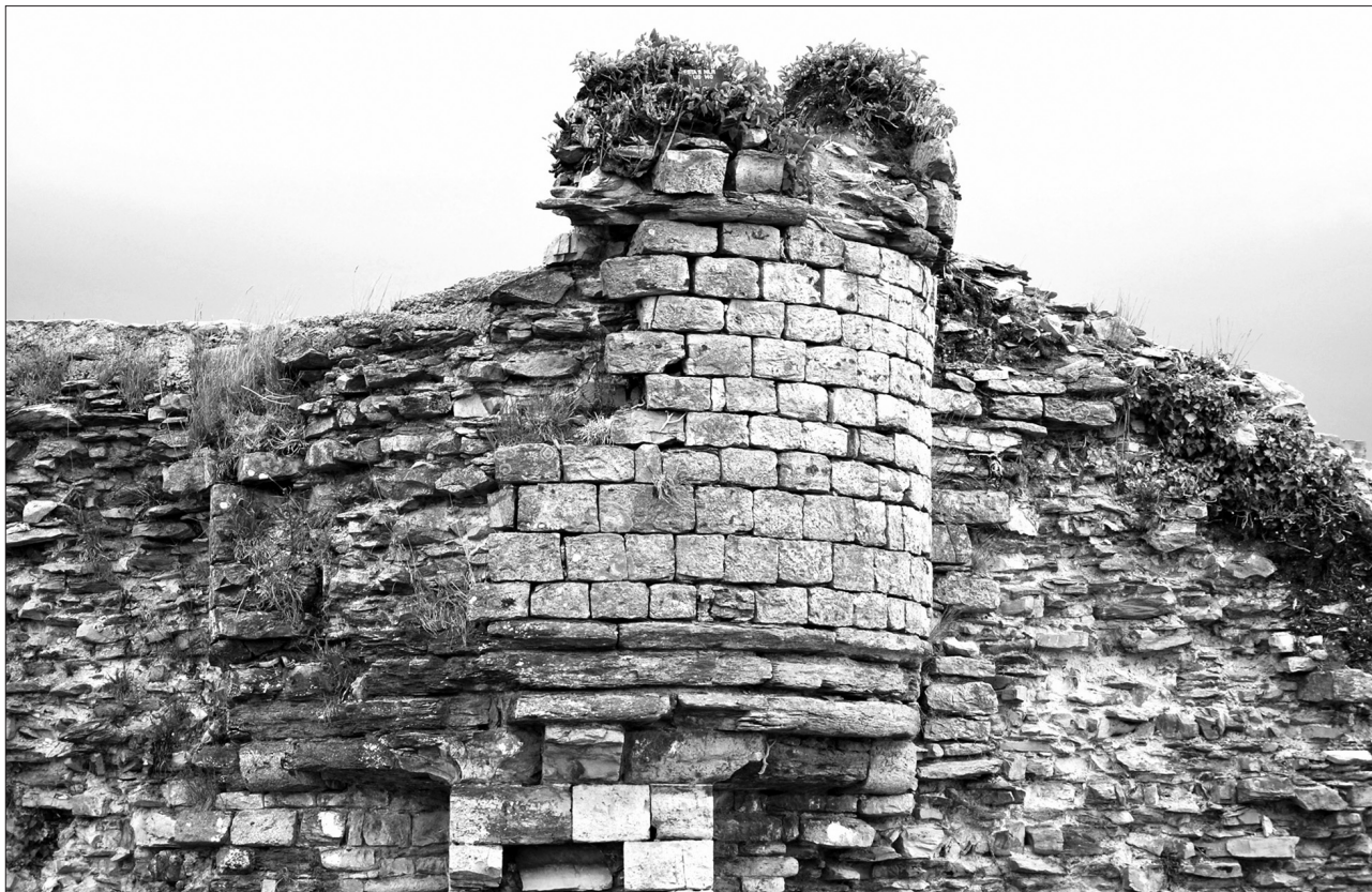
Détail d'une des tourelles sur contrefort.
