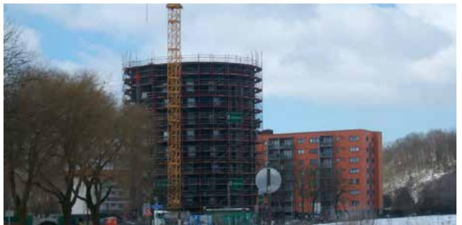
Au niveau structurel, la tour est composée de dalles et voiles intérieurs en béton. Entre les dalles, la fermeture du bâtiment a été réalisée à l'aide de panneaux préfabriqués (et pré-isolés) en bois derrière lesquels a été érigée une contre cloison en bloc silico-calcaire de 9 cm. Cette contre cloison a plusieurs fonctions :
