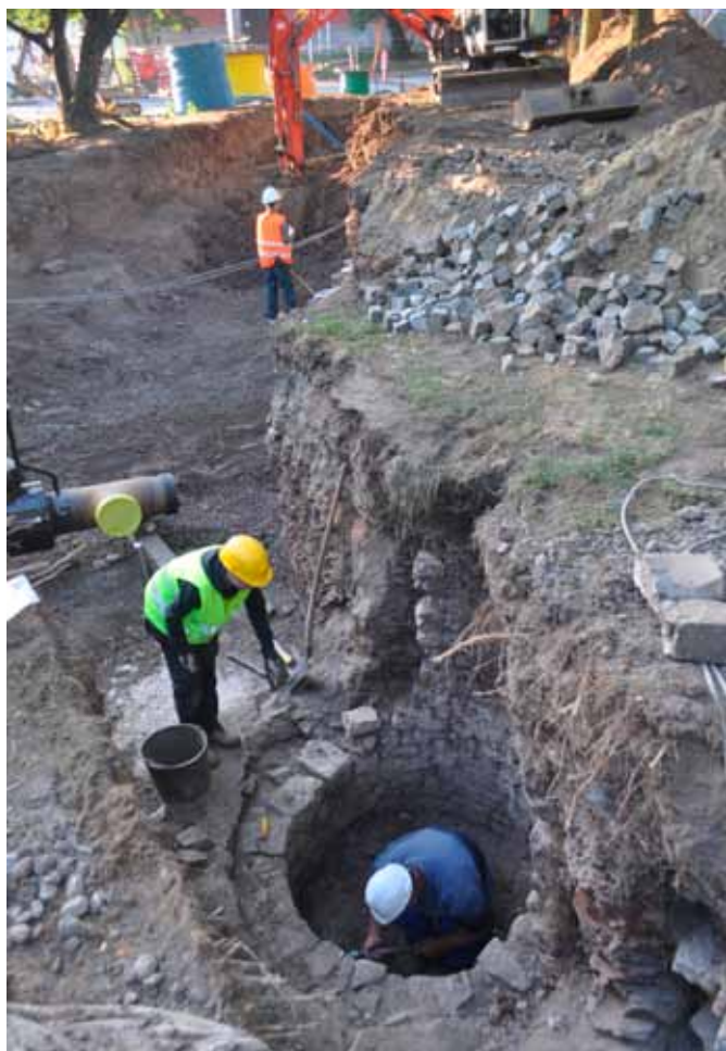
Suivi archéologique au Grognon : à chaque tranchée de nouvelles découvertes... © SPW
